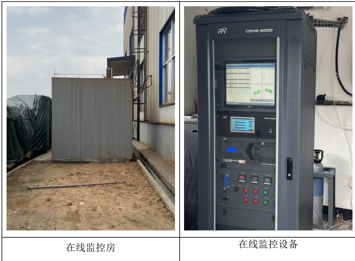
图 4.1-12 生物质炭废气在线监测设施现场情况
